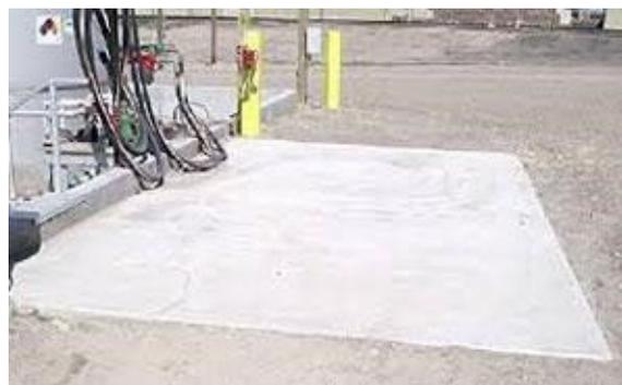
Plataforma de contención impermeable
